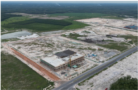
凯迪国际（越南）新建厂房项目
