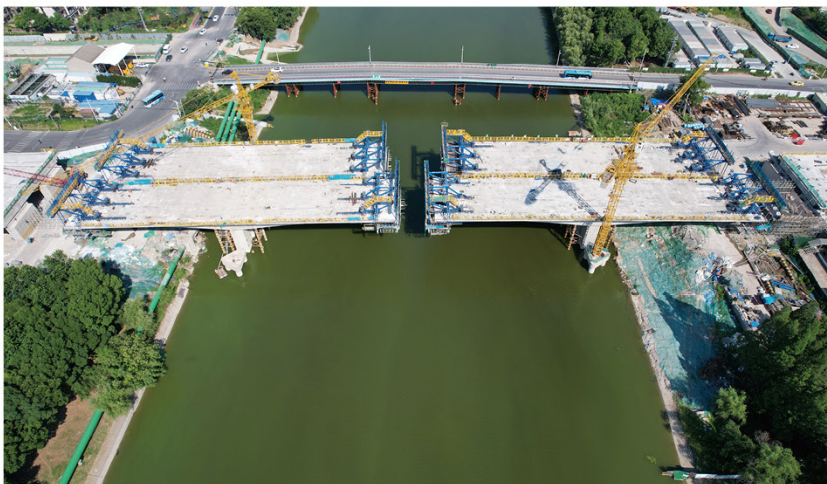
南京兴梅路项目桥面施工
