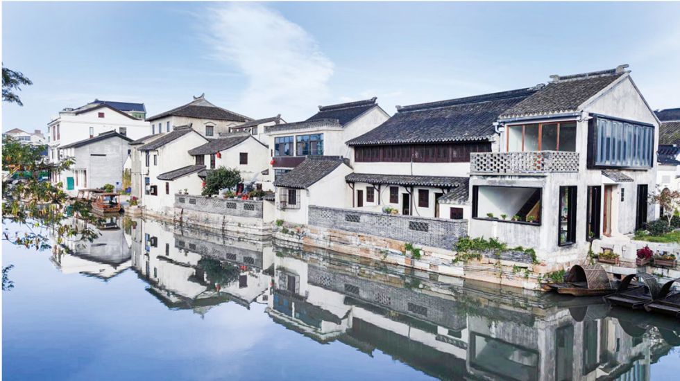
吴江区平望古镇综合提升修缮项目
