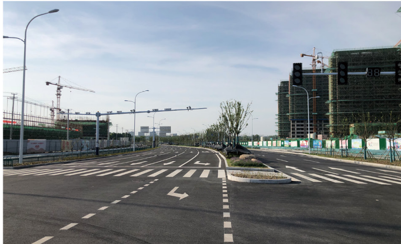
肥东县四顶山路及四顶山路跨规划南沙河桥桥梁工程顺利通过完工验收
