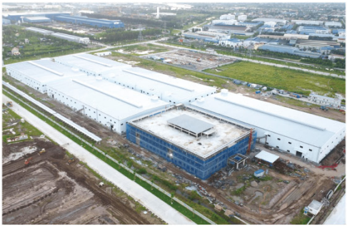
越南海防巨星智能新建厂房项目
