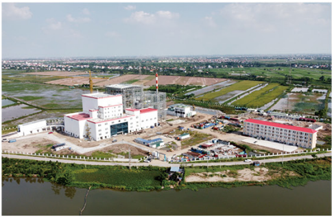
越南北宁海创垃圾发电厂项目
