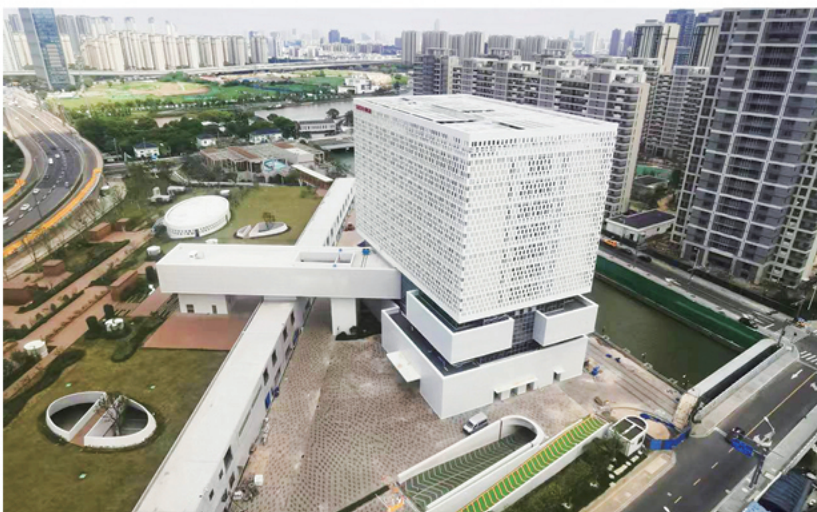
苏州新区污水处理厂综合办公楼
