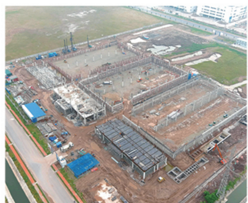
越南河南金箭科技营造一期项目
