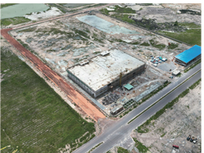
越南凯迪国际新建厂房项目
