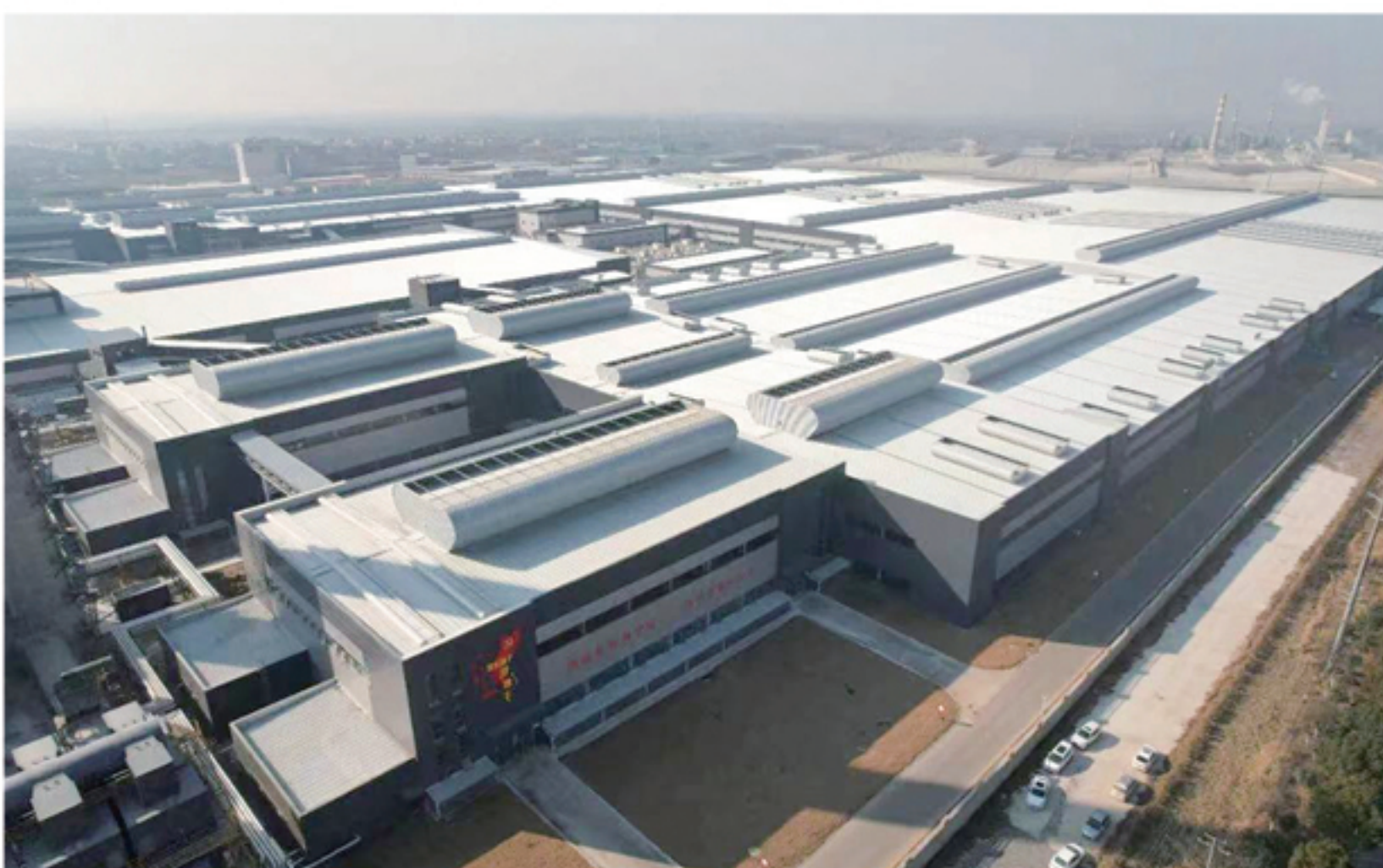
安徽福莱特二期光伏联合车间（一）、（二）钢结构工程
