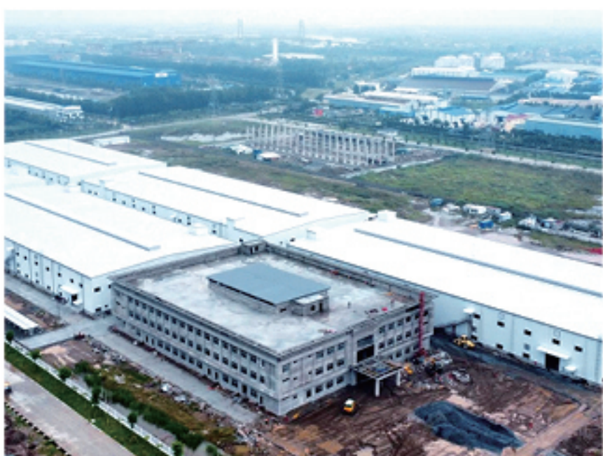
越南海防巨星智能新建厂房项目
