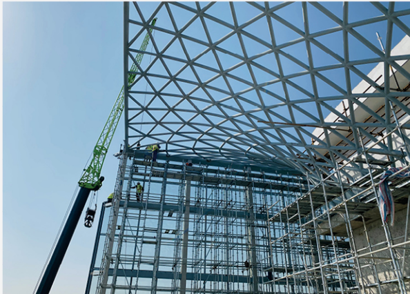
项目钢结构专业施工
