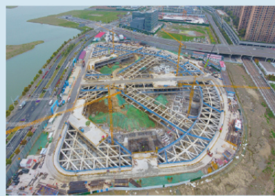
中荷（苏州）科技创新港项目
