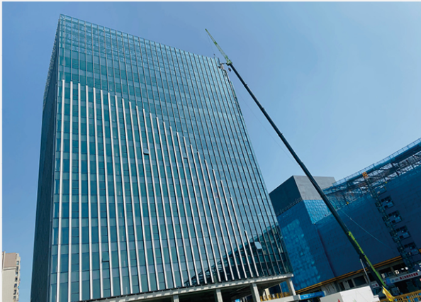
研发楼单元幕墙吊装中
