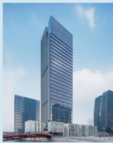
紫光大厦项目
