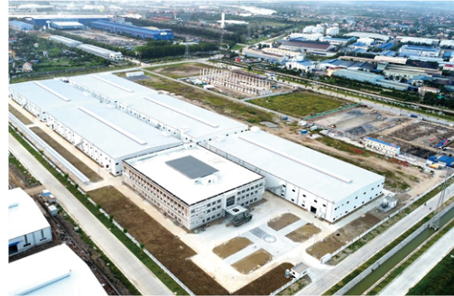
越南海防巨星智能新建厂房项目
