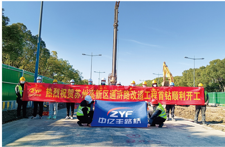
中亿丰路桥通浒路改造工程首钻顺利开工
