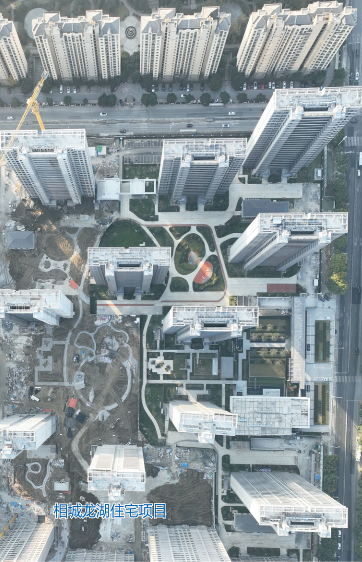
苏州高泰电子总部大楼项目
