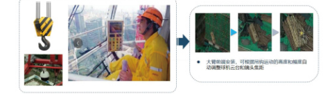
图4 智慧塔吊远程可视化监控
