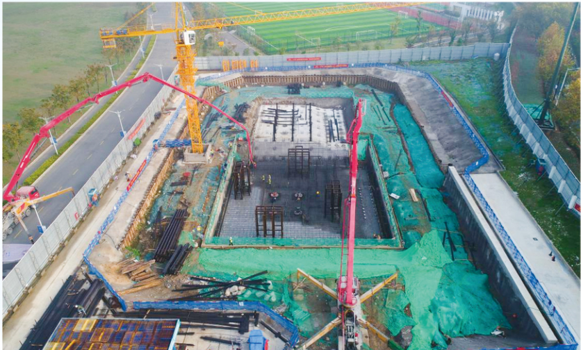
苏州科技大学地震模拟振动台实验室项目
