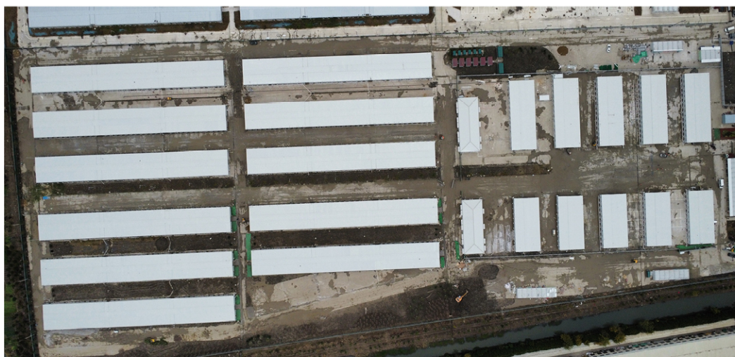
归来宋家港邻里中心三期应急工程
