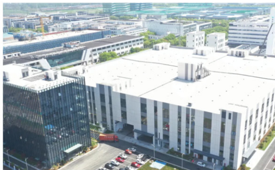
华亚智能化新建EPC项目
