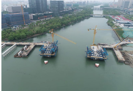
苏州工业园区凤里街南延(淞北路-金鸡湖大道)工程
