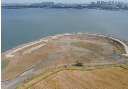
阳澄湖西湖屏障带工程
