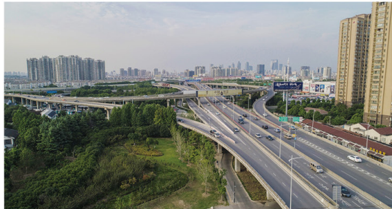
东环南延高架桥
