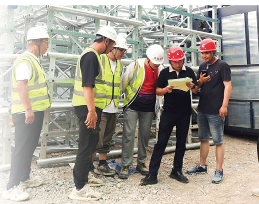
中亿丰工程师在新疆项目工地指导智能无人施工电梯安装
