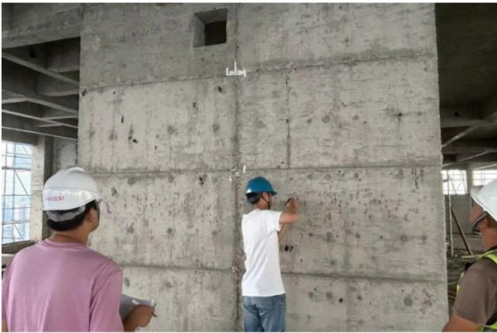
工地进行实体检测
