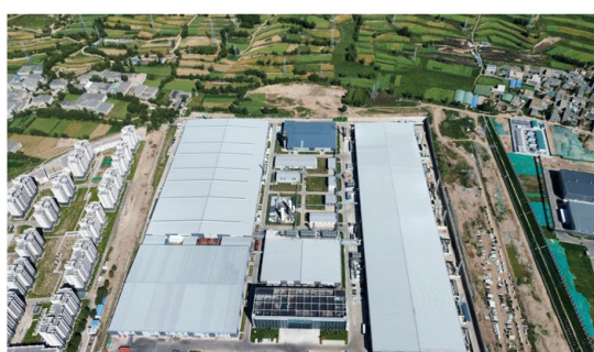
西宁天合三期 EPC 总承包项目
